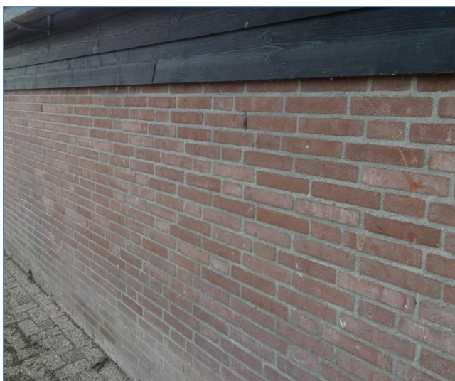
Foto 13 Zijgevel oost van planlocatie 1 met enkele, lage open stootvoegen
