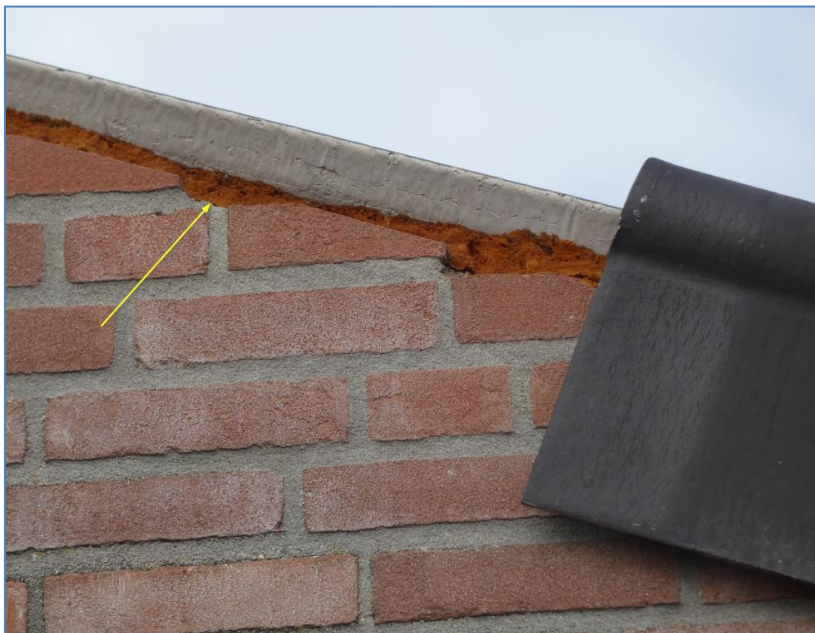
Foto 15 Dicht-‘gepurde’ afsluiting kopgevels en dakbeplating
