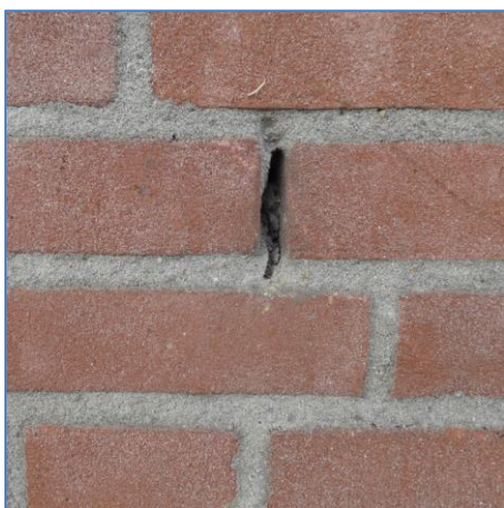
Foto 14 Open stootvoeg zijgevel oost blijken dicht met specie
