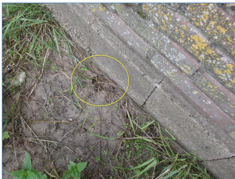
Foto 17 hol naast westgevel gebouw 1a
