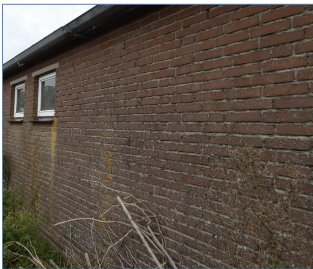
Foto 12 Dichte zijgevel west
