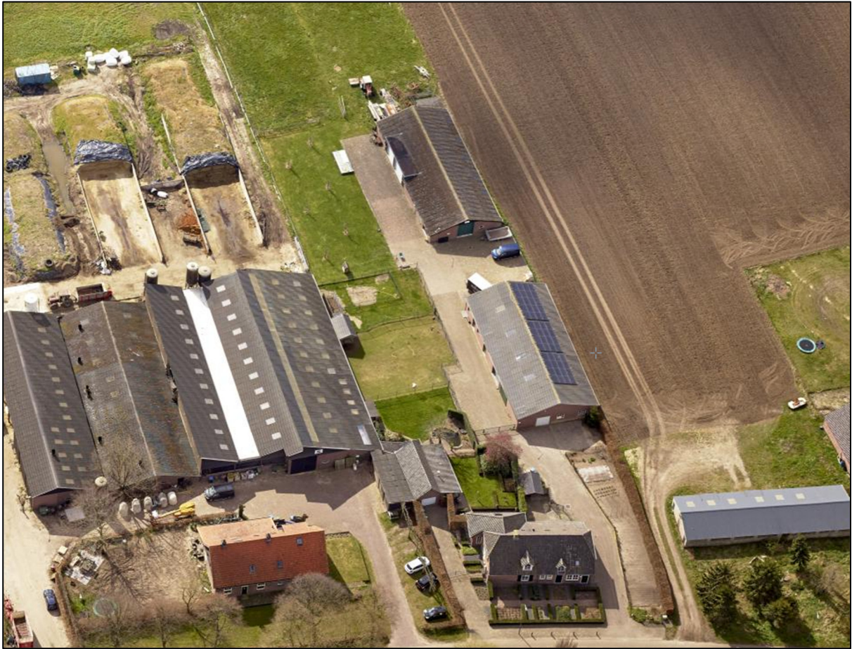
Afbeelding 3 Drone-opname plangebied (d.d. 3 april 2022, zuidaanzicht)
