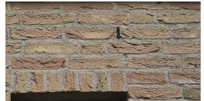
Figuur 5: Bijenbekje binnen open stootvoeg
