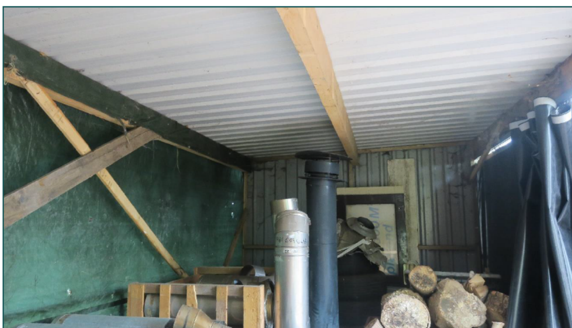
Figuur 2 De bebouwing bestaat uit damwandplaten en hout.
