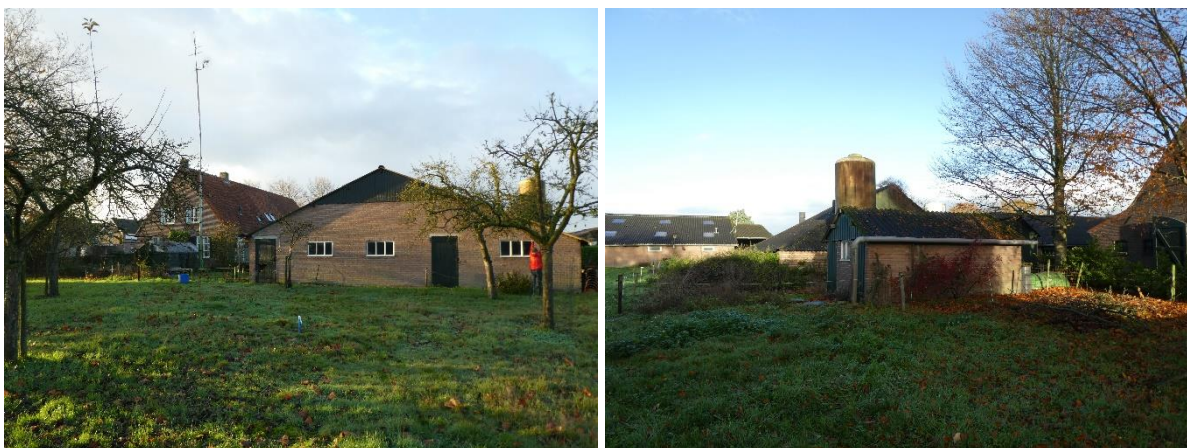
Afbeelding 7 en 8: Aangrenzende beplantingen nabij te slopen bebouwingen. Bron: BNL advies. Datum: 07-12-2022
