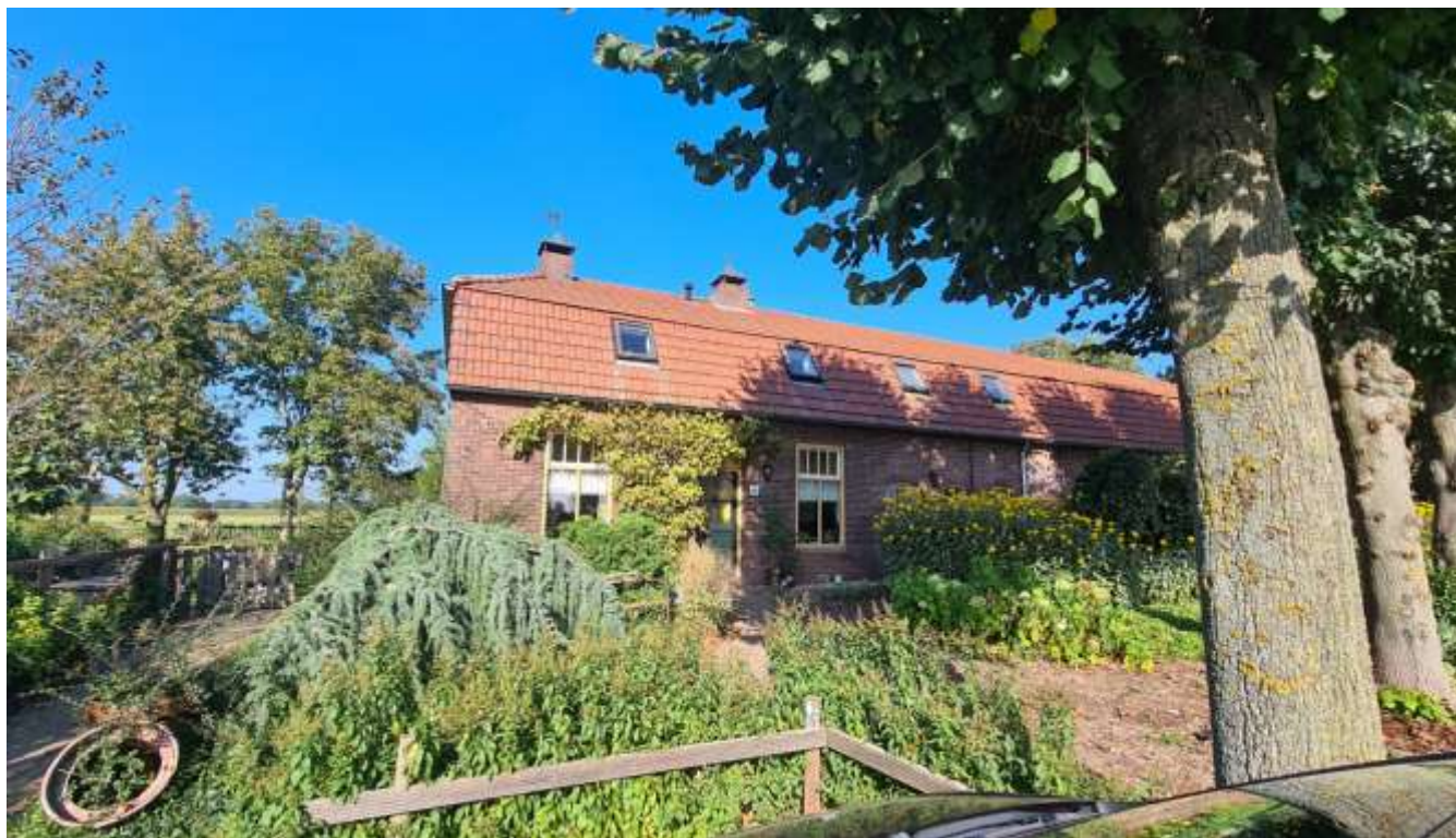
Figuur 4: Plangebied gezien vanuit het zuiden
