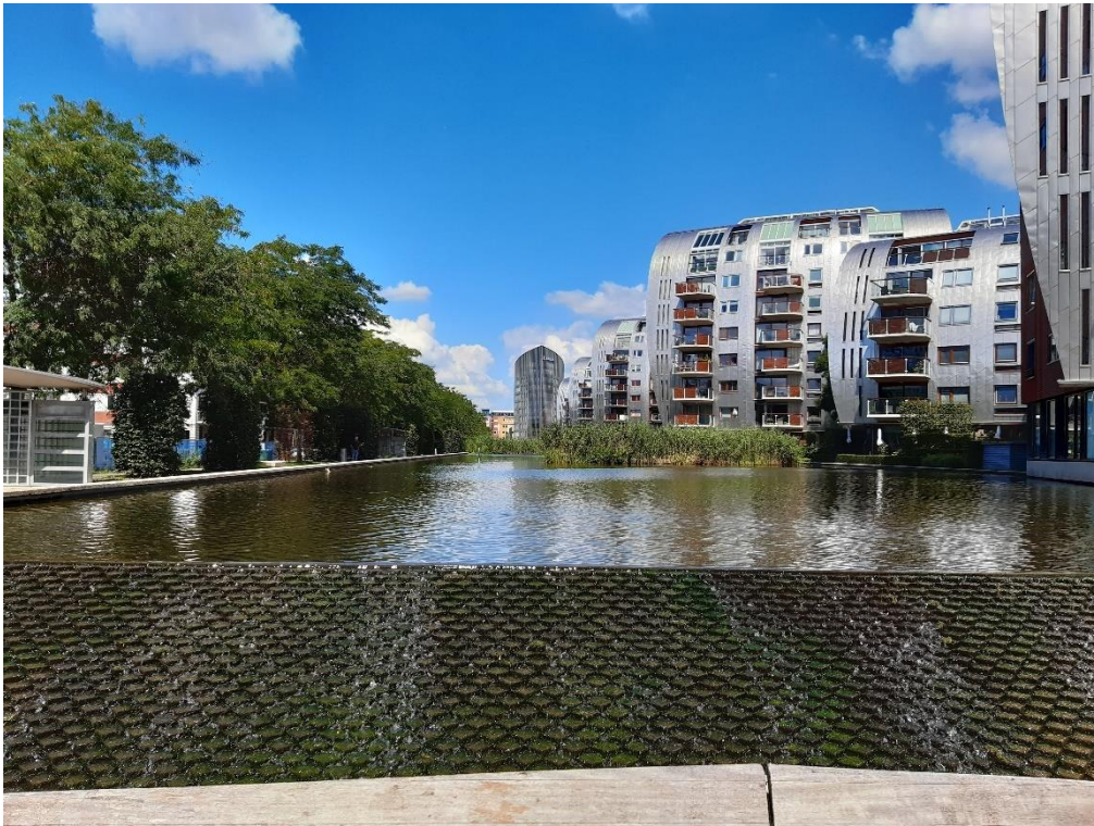
Figuur 12. De vijver ten oosten van het plangebied die aansluit op de Hofvijver ten zuiden van het plangebied. Op de voorgrond is een van de twee watervallen te zien die de verbinding vormen tussen de twee vijvers.
