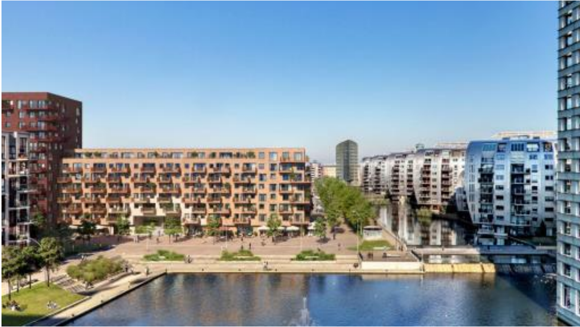
Figuur 2. Artist impression van het in aanbouw zijnde gebouw Palazzo (links op de afbeelding), afkomstig van de site https://www.woneninpalazzo.nl/ . Het plangebied ligt tussen dit gebouw en de Hofvijver (op de voorgrond).
