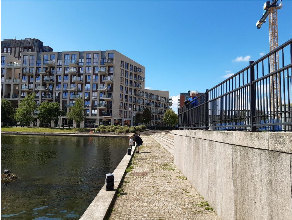
Figuur 8. Het plangebied gezien vanuit oostelijke richting. Op de achtergrond is een gebouw te zien dat direct grenst aan het plangebied. Ook zijn bomen te zien die binnen het plangebied staan of in de directe omgeving ervan.
