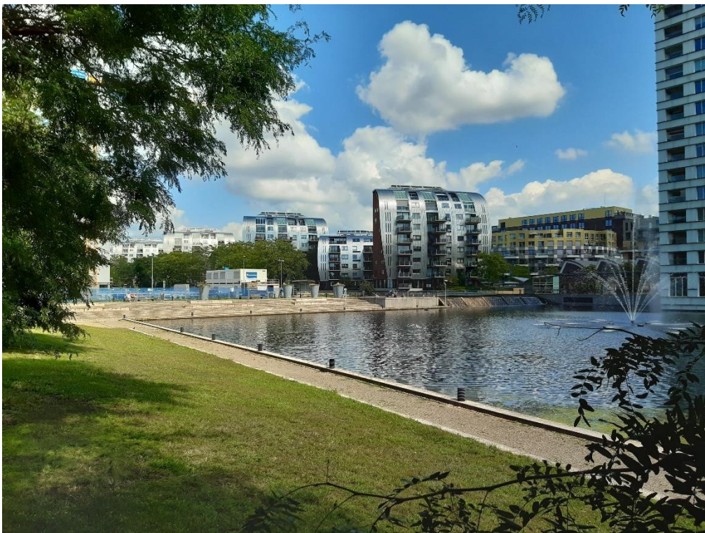
Figuur 7. Het plangebied gezien vanuit zuidwestelijke richting. Linksachter is het bouwterrein te zien waar de nieuwbouw Palazzo verrijst.
