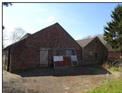
Figuur 7. Meest oostelijke aaneengeschakelde schuur met zowel dakpannen dak als golfplaten dak.
