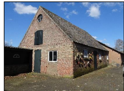
Figuur 5. Aaneengeschakelde schuur in midden onderzoekslocatie, met dakpannen dak aan de voorzijde en golfplaten dak aan de achterzijde.
