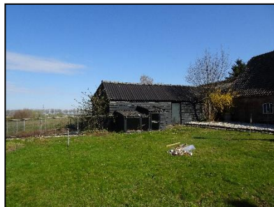
Figuur 4. Meest westelijke schuur met golfplaten dak en leegstaand kippenkooi.
