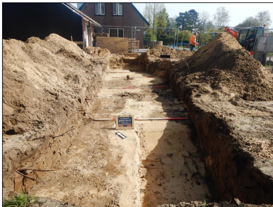
Figuur 4 Overzichtsfoto proefsleuf, Werkput 1 (foto genomen naar het noordoosten)
