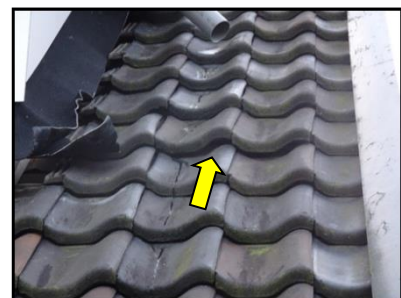
Figuur 13. Ruimte onder de dakpannen.
