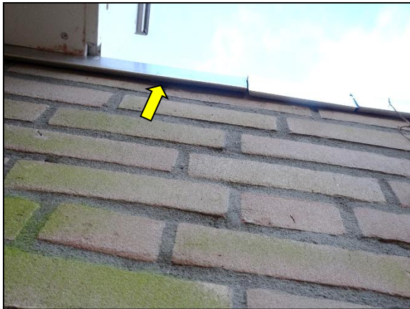
Figuur 15. Ruimte onder de daktrim.
