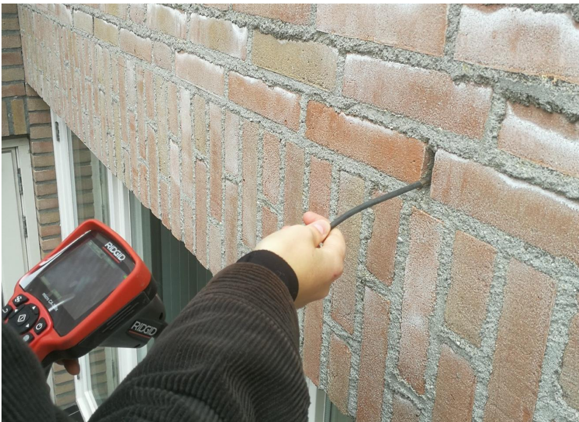
Figuur 2 Endoscooponderzoek. Alle stootvoegen en andere openingen in de bebouwing zijn onderzocht met behulp van een endoscoopcamera.
