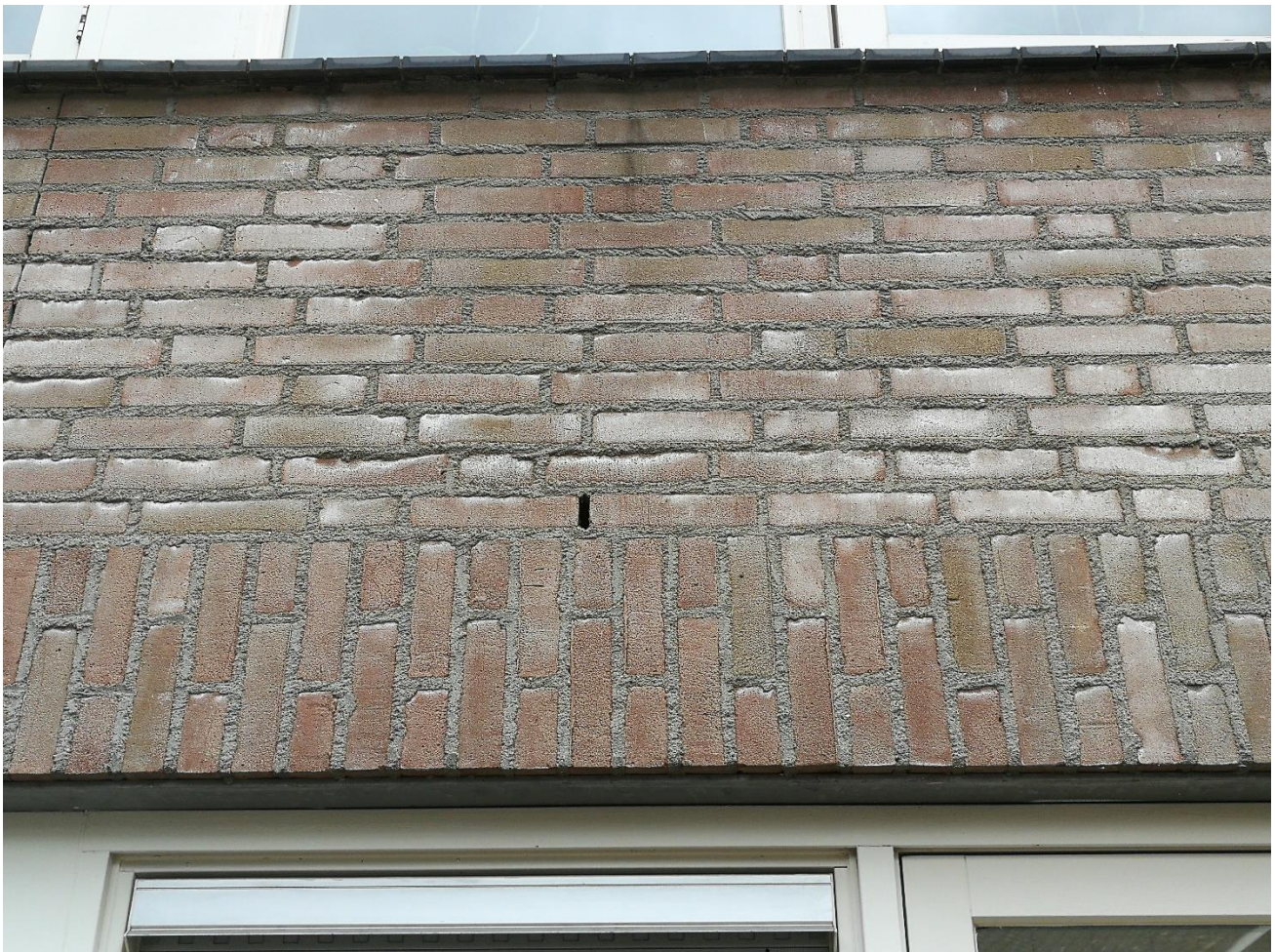
Figuur 11 Eén van de onderzochte stootvoegen.
