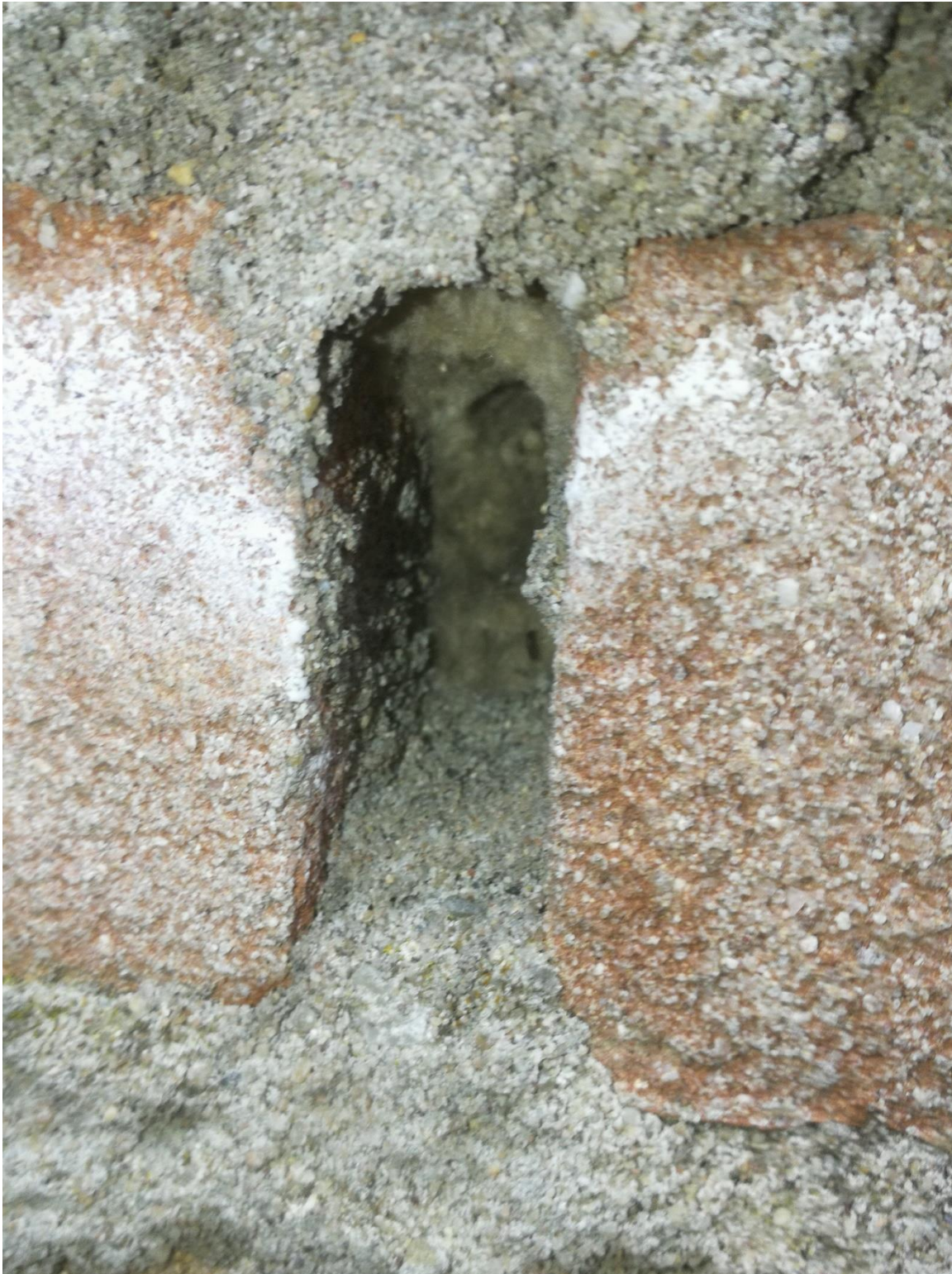
Figuur 12 Isolatiemateriaal direct achter open stootvoeg.
