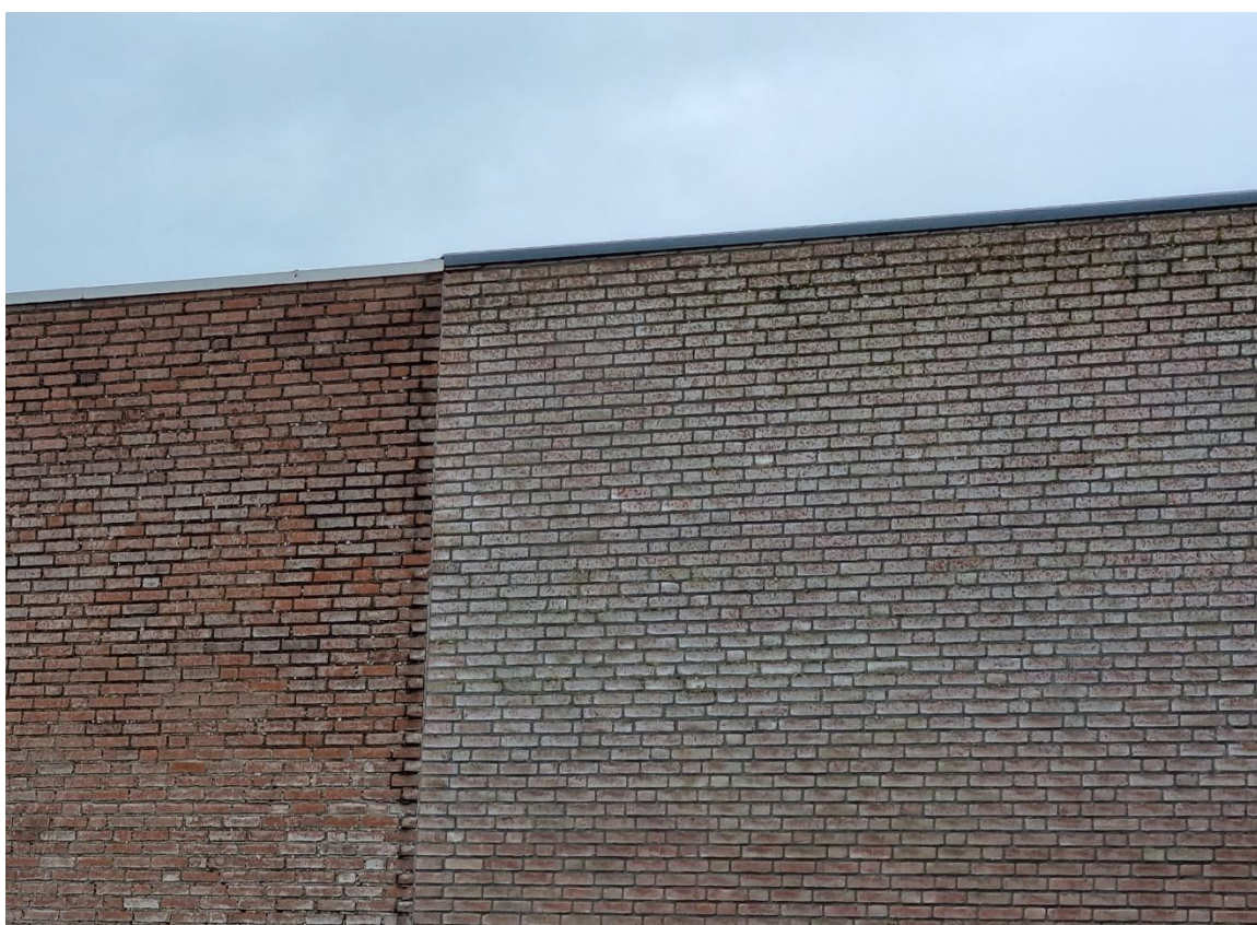
Figuur 7 Deel van de westelijk gelegen gevel, met de scheiding tussen het deel met (rechts op de afbeelding) en het deel zonder (links op de afbeelding) open stootvoegen in de buitenmuur.
