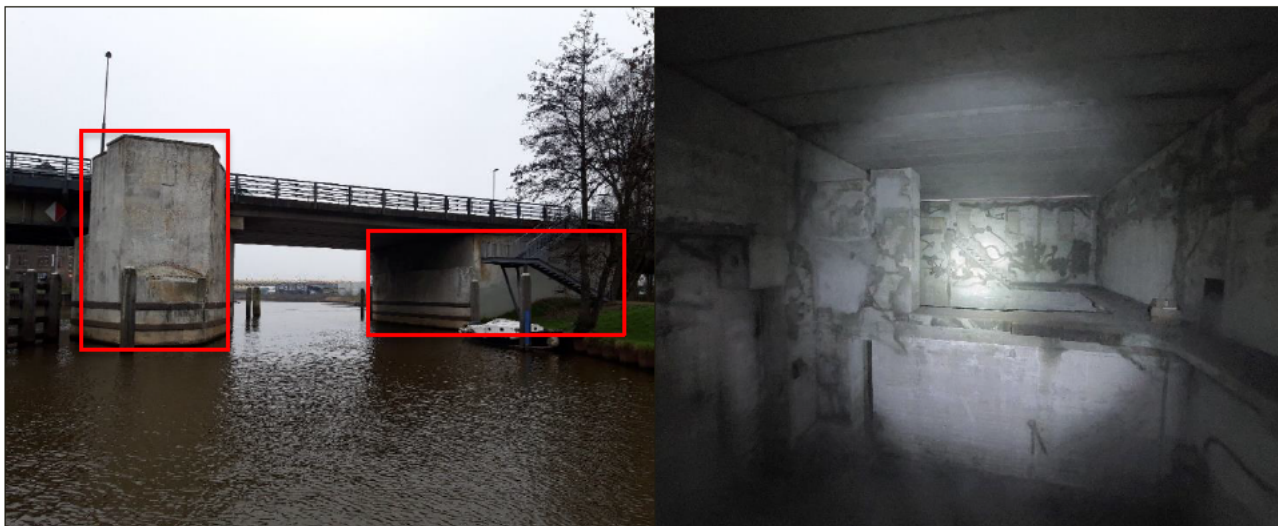
Afbeelding 1.3 de twee brugpillaren (rood omkaderd) gezien vanaf het water (links), beide pilaren bevatten bascule kelders (rechts).
