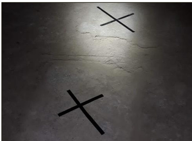
Afbeelding 2.1 Geplaatste kruisen ten behoeve van controle uitwerpselen vleermuizen in de noordelijke basculekelder.
