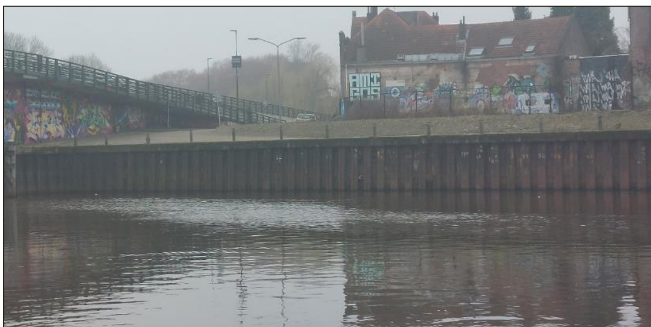
Afbeelding 3.4 Situatie Diezebrug aan de zuidwestzijde.
