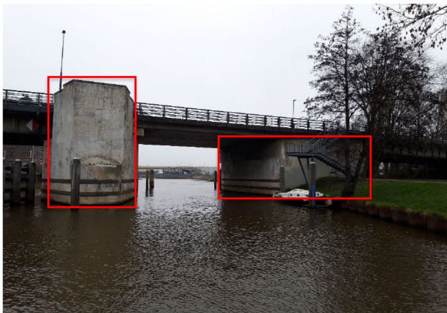
Afbeelding 3.1 de twee brugpilaren (rood omkaderd) gezien vanaf het water. Beide pilaren bevatten bascule kelders.
