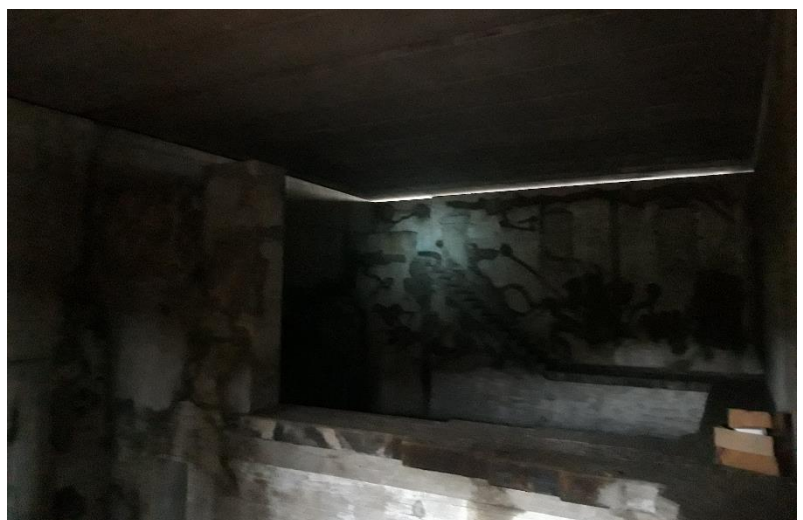
Afbeelding 4.2 Grote bascule kelder. Op de foto is duidelijk de ruimte tussen brugdelen en kelder te zien.
