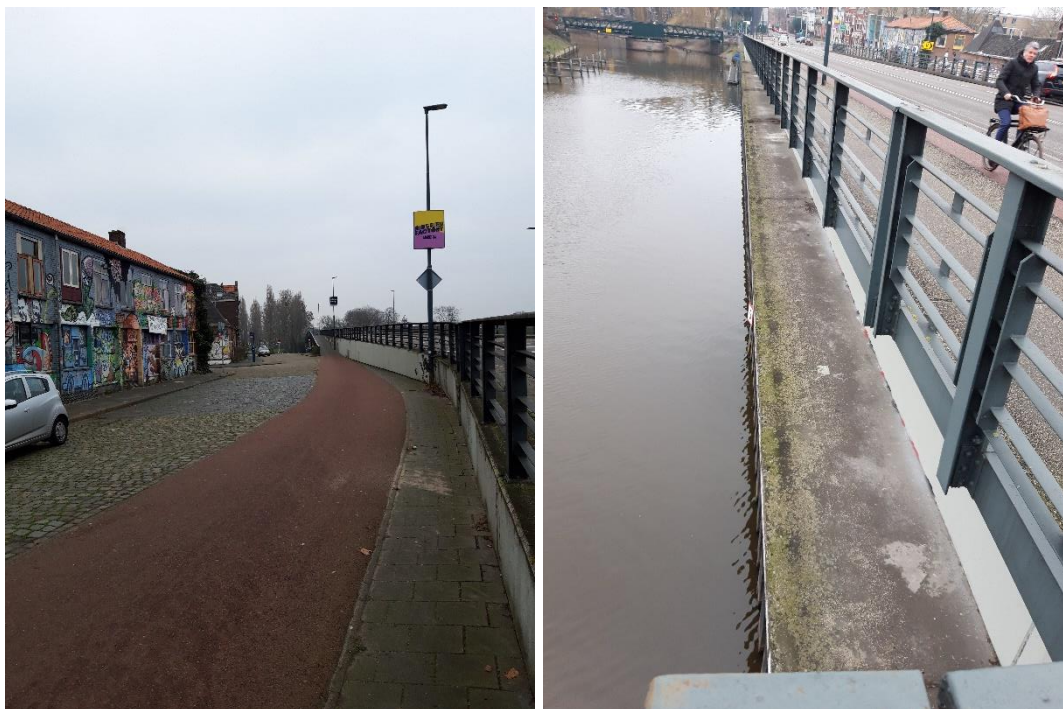
Afbeelding 3.3 Linker foto genomen van de zuidzijde aan de westkant. De rechter foto is genomen vanaf de brug naar het zuiden toe aan de oostkant.
