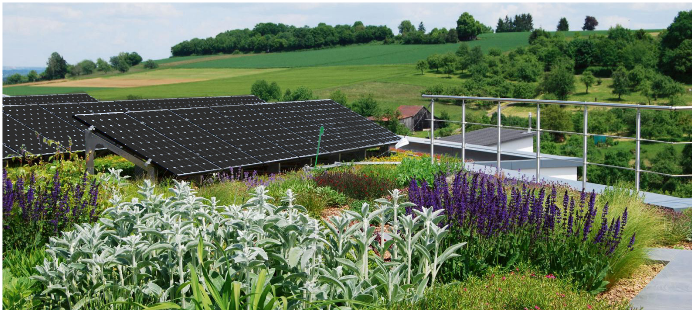
Daken met zonnepanelen en biodivers groen
