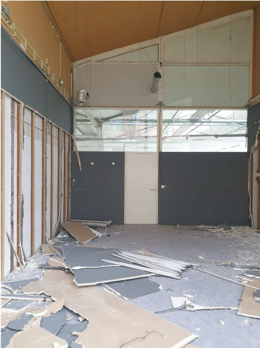
Foto 6, geen sloopwerkzaamheden in uitvoer aan de Onderwijsboulevard 256 te 's-Hertogenbosch.
