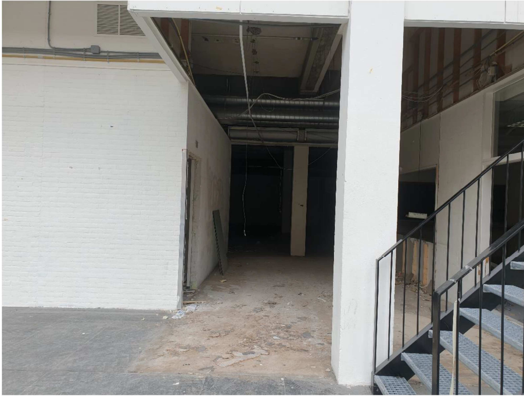
Foto 5, entree Onderwijsboulevard 256 te 's-Hertogenbosch: geen sloopwerkzaamheden in uitvoer.
