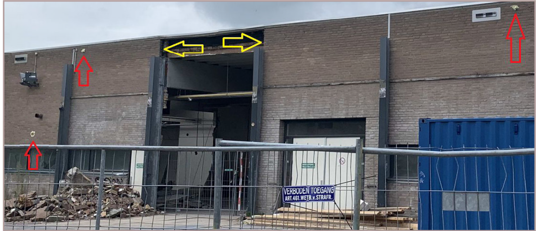
Figuur 2 Representatief deel van de gevel. In rood: gedichte gaten. In geel: nog af te dichten openingen die zijn ontstaan door het vergroten van de aanwezig toegang.
