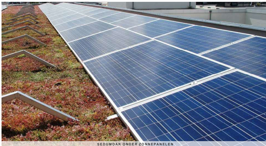
SEDUMDAK ONDER ZONNEPANELEN
