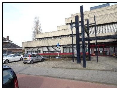
Figuur 7. Oostzijde bebouwing.
