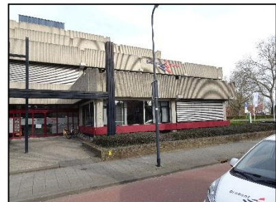
Figuur 5. Oostzijde bebouwing.
