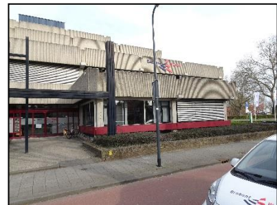
Figuur 5. Oostzijde bebouwing.
