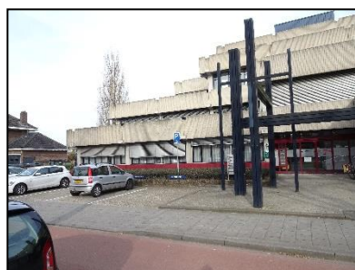
Figuur 7. Oostzijde bebouwing.
