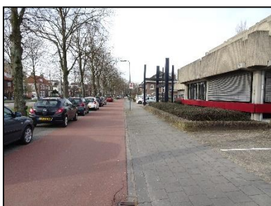
Figuur 6. Oostzijde bebouwing en straatbeeld
