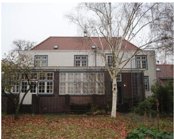
Afbeelding 6. Achtergevel aan de zuidkant van de pastorie, met de tuin op de voorgrond.
