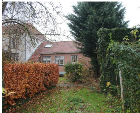
Afbeelding 5. Achtergevel aan de zuidkant van de pastorie met op de voorgrond het oostelijk deel van de pastorietuin
