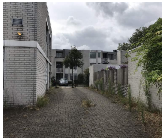
Afbeelding 5. Oprit naar de parkeerplaats, aan de westzijde van het kantoorgebouw.
