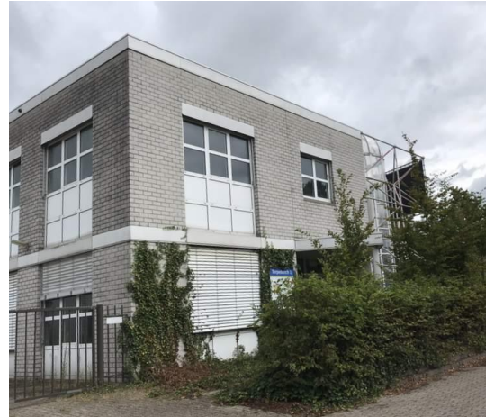
Afbeelding 3. Het kantoorgebouw gezien vanaf de Terpeborch.
