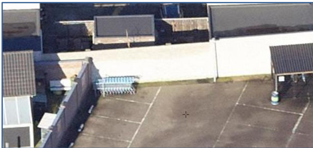
Afbeelding 4. Bestaande afschermende voorzieningen
