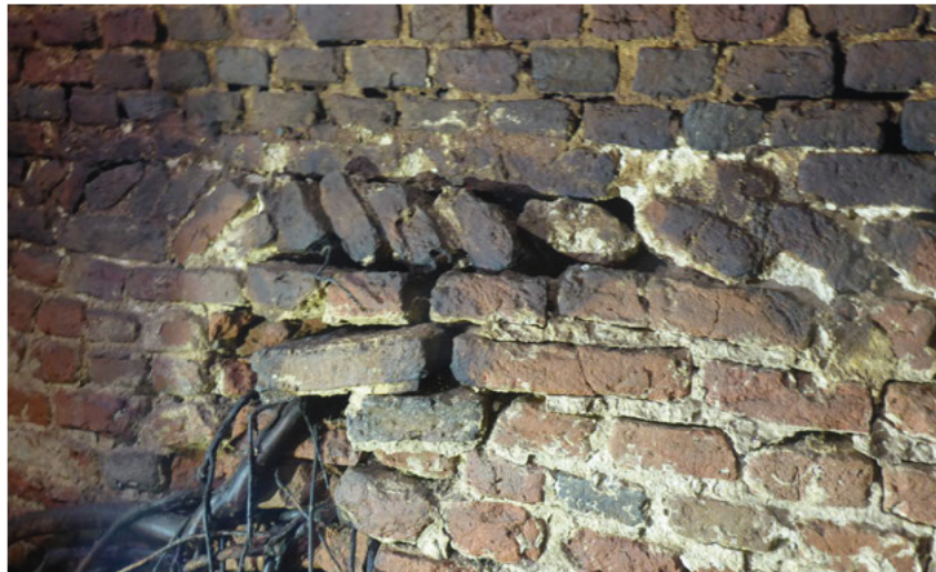
Afb. 4.3 Stroomlaag ingemetseld aan de zuidzijde van de binnenkant van het gewelf.
