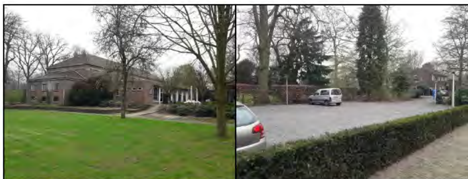
Figuur 3.5a (linkerfoto): Zicht op het pand "de Uythof" gezien vanaf boring 30 kijkende in noordoostelijke richting (d.d. 13-04-2018). Op de voorgrond het grasperceel dat circa 1,5 m lager ligt dan de verharde zone rondom het gebouw.
