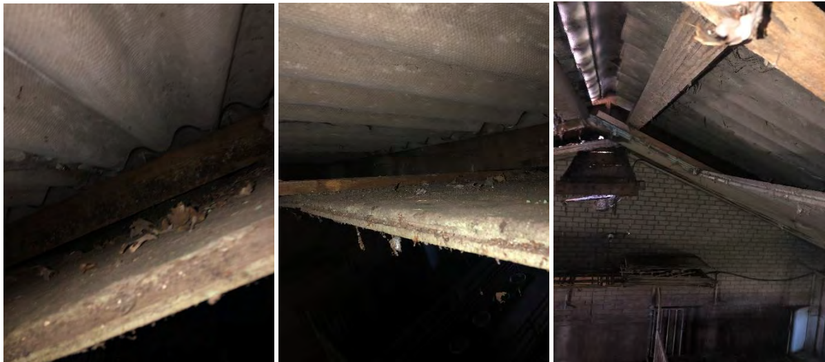
Afbeelding 7 en 8: Locatie tussen dakplaten en isolatieplaten nader geïnspecteerd op sporen van uilen.. Bron: R.J.L. Bijvelds Datum: 01-04-2021
