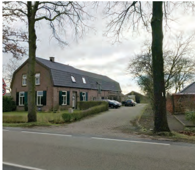
Beeld situatie langevelboerderij Vinkelsestraat 135 west-zijde
