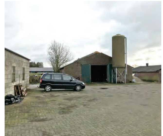
Beeld bestaande schuren Vinkelsestraat 135 achter bedrijfswoning
