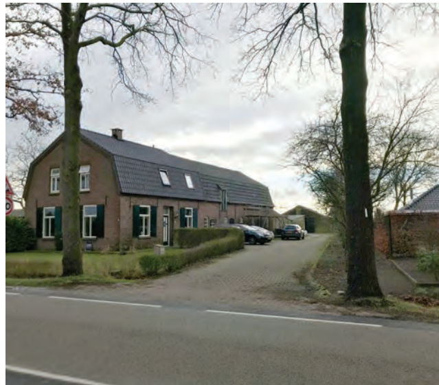
Beeld situatie langevelboerderij Vinkelsestraat 135 west-zijde
