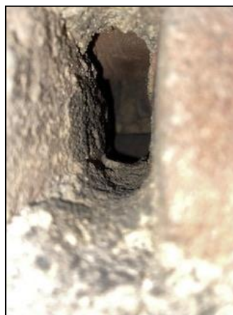
Figuur 6. Open stootvoeg in flat 4 biedt toegang tot de spouwmuur.
