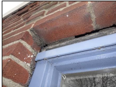
Figuur 2. Kier langs raamkozijn biedt toegang tot achterliggende ruimte.
