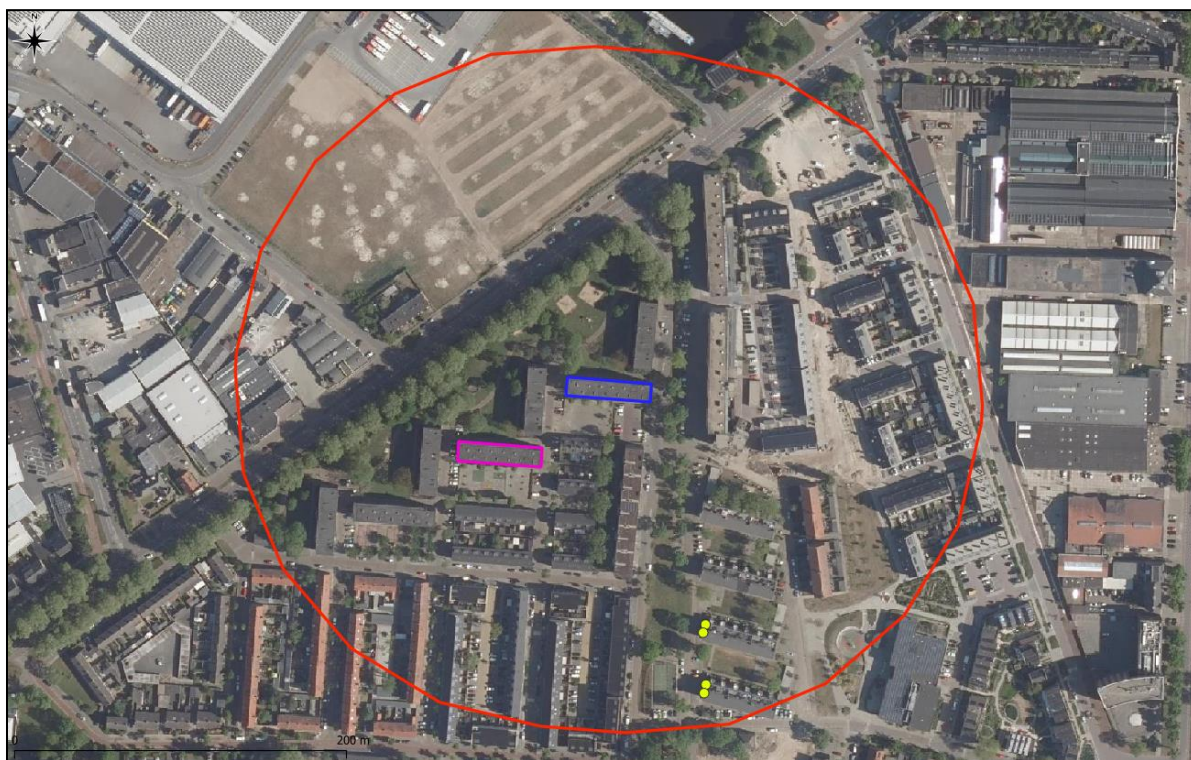
Figuur 7. Luchtfoto met flat 2 (blauw kader) en flat 4 (paars kader) en tijdelijke vleermuiskasten die ruimschoots voor februari 2020 zijn opgehangen (geel cirkels). Deze tijdelijke vleermuiskasten ten behoeve van de aangetroffen paarverblijfplaats vallen binnen een straal van 200 meter (rode cirkel) rondom flat 2.
