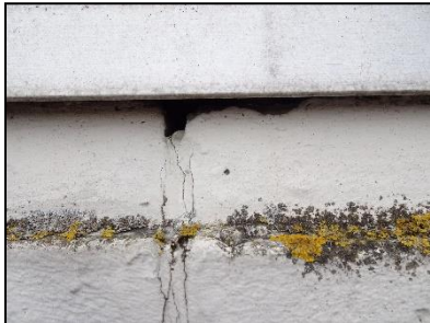
Figuur 1. Ruimte onder de daktrim met toegang tot achterliggende ruimte.
