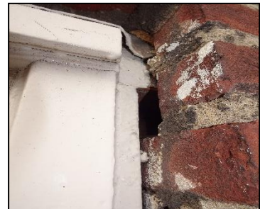
Figuur 3. Kier langs raamkozijn biedt toegang tot achterliggende ruimte.
