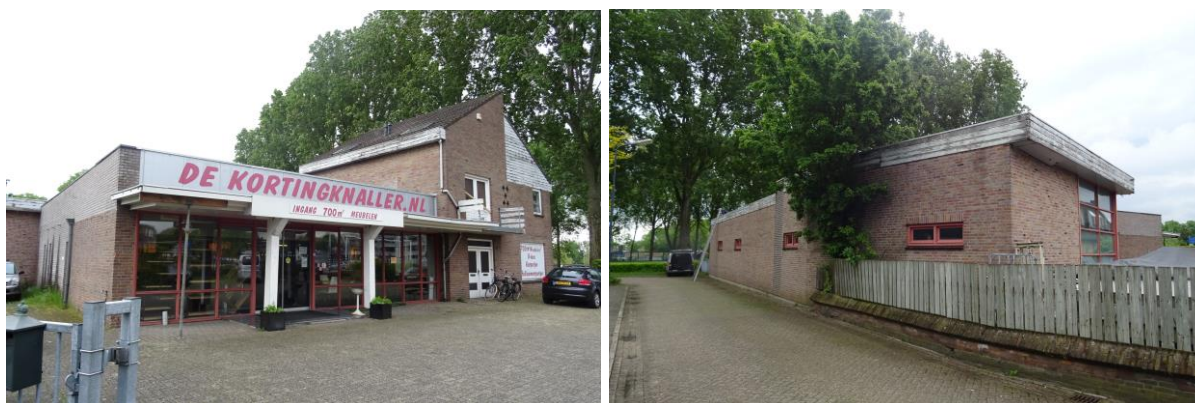
Afbeelding 3 en 4: Te slopen winkelpand. Bron: R.J.L. Bijvelds. Datum: 25-05-2021
