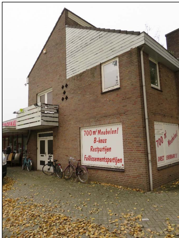
Foto 1. Deel met schuin dak en gevelbetimmering
