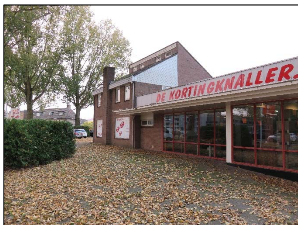
Foto 5. Gebouw gezien vanuit het westen
