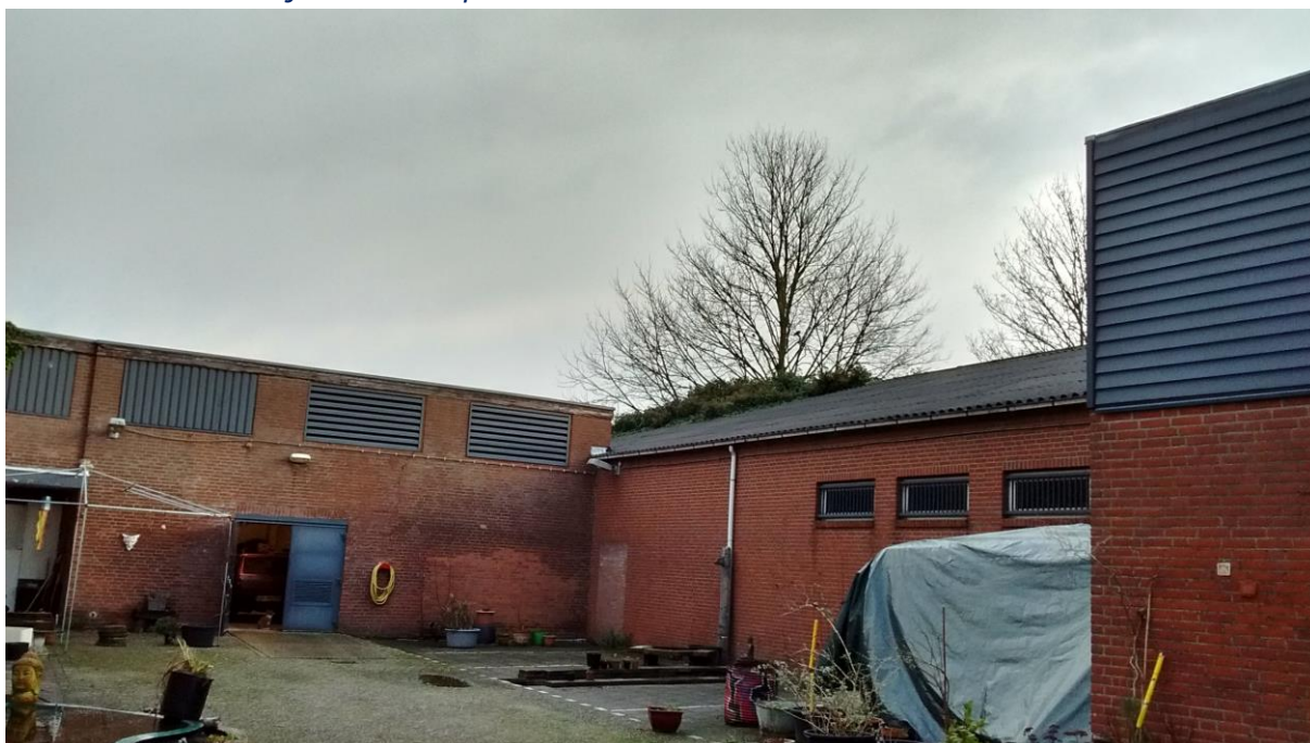
Muur aan de westzijde van het pand:
