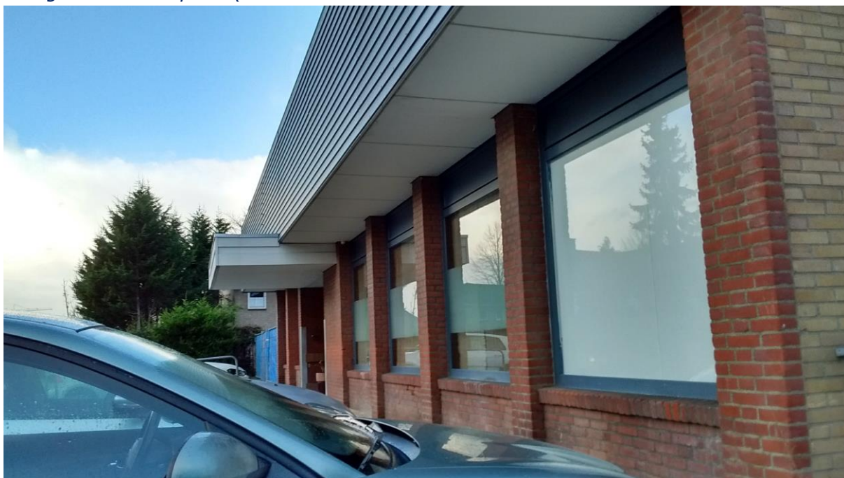
Voorgevel van het pand (zuiden:
