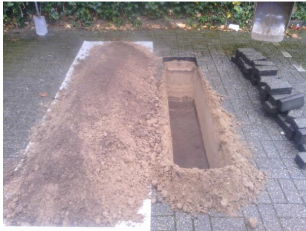
Foto 4: Open gegraven sleuf
