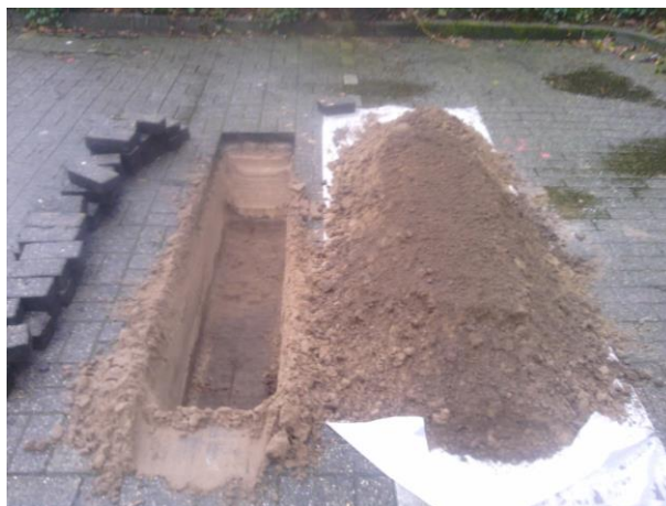
Foto 5: Open gegraven sleuf
