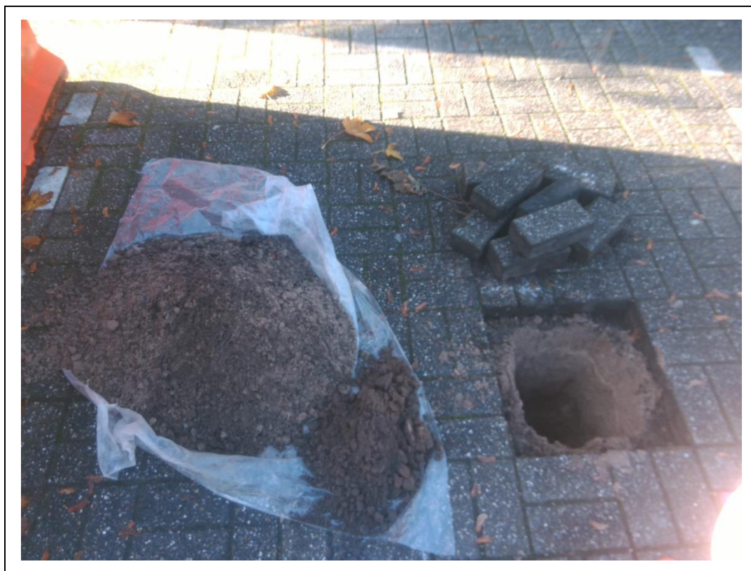
Foto 14. Asbestinspectiegat E14
