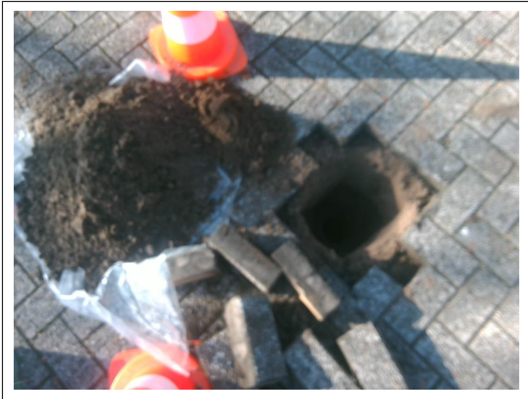
Foto 15. Asbestinspectiegat E15
