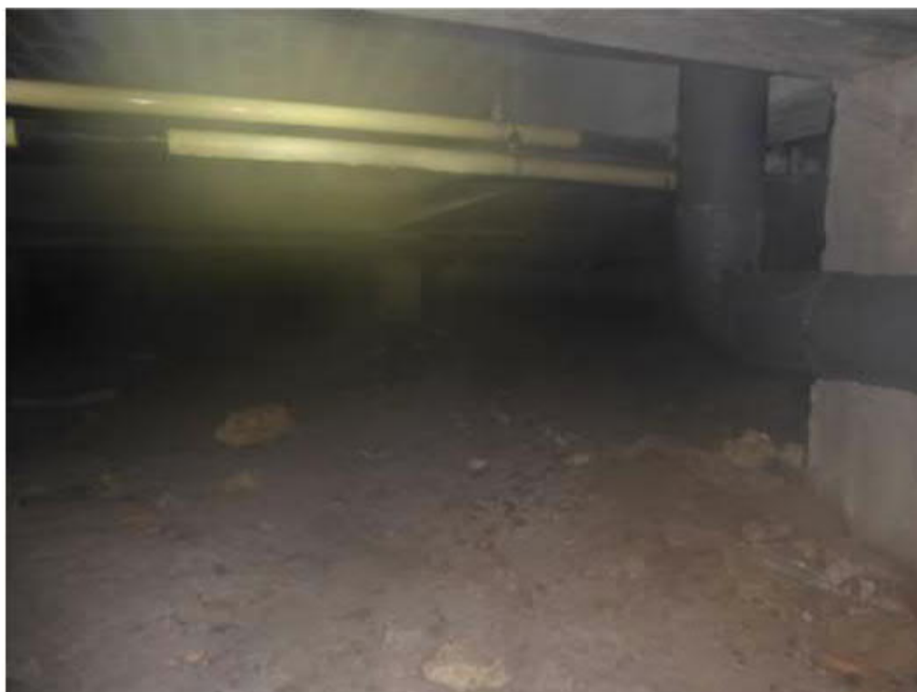
Figuur 12. De kruipruimte onder het gebouw is ook onderzocht tijdens de quickscan.
