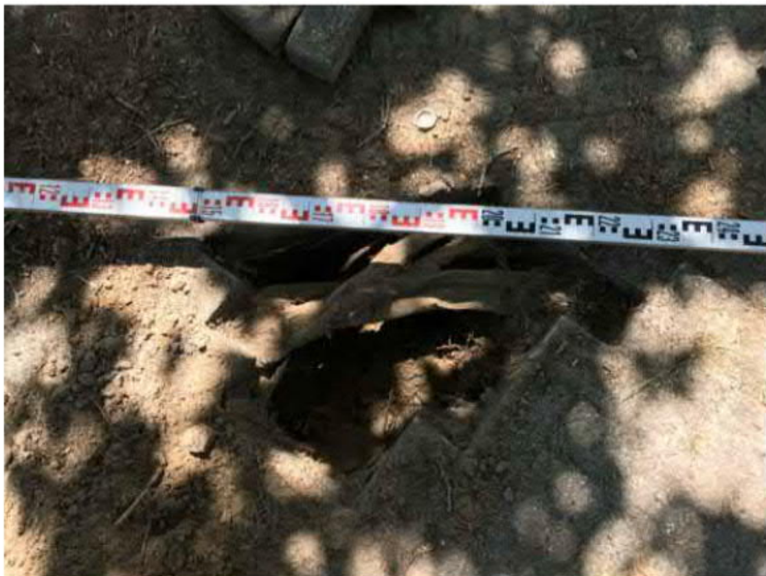
Figuur 9 Aangetroffen situatie in profielsleuf 3, met zichtbare stabiliteitswortels direct onder de verharding. De baak toont de afstand tot de stamvoet van de plataan aan.
