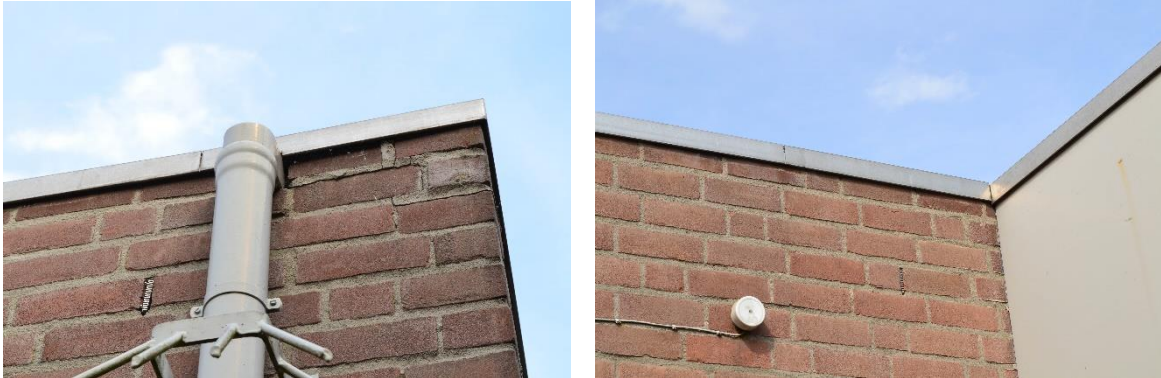
Figuur 3. Bijna alle open stootvoegen van gebouw binnen het plangebied zijn afgesloten met zogenaamde bijenbekjes. Het platte dak is afgewerkt met daklijsten, waarmee de spouwmuur mogelijk toegankelijk is voor vleermuizen.
