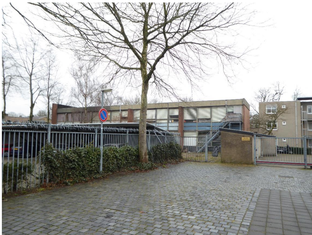
Figuur 5. De achterzijde van het voormalige schoolgebouw.
