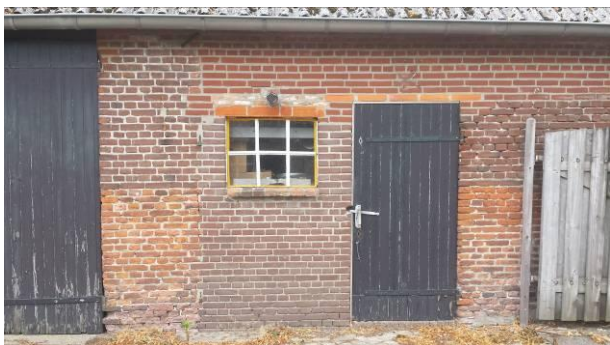
Foto links: de dicht gezette sparing van de voormalige mestdeuren, hierbij vervangen door een loopdeur en en stalen raampje.
