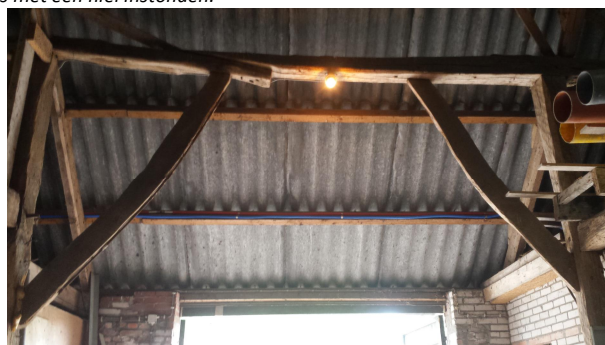
Foto rechts: aansluiting van het oorspronkelijke gebint (links) aan de uitbreiding van het schuurgedeelte (rechts) op 2 tussen E en F.
