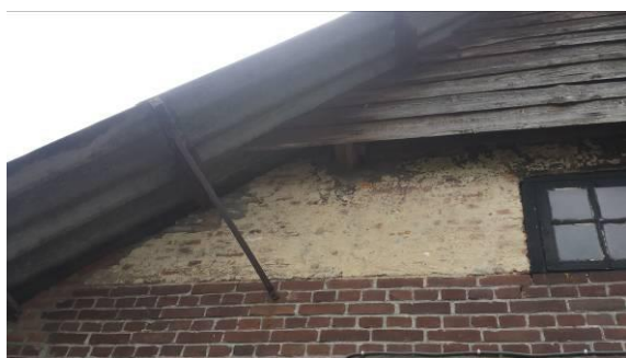
foto: het bovenste gedeelte van de kopgevel met (besmeerde) ijsselsteentjes.
