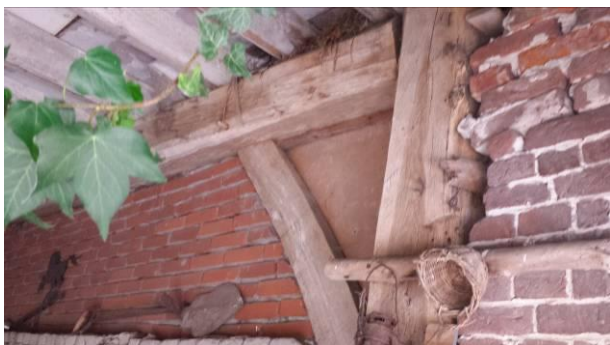
Foto links: gebint in de kopgevel van de hoofdbouw van de boerderij, binnen in de afdang/karschop | foto rechts: sporen van gefaseerde ophoging van de daklijn in de kopgevel als gevolg van ophogen van de zuidgevel en aanpassingen aan de kap.
