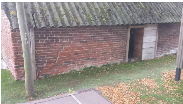
Foto links: achterzijde van de westgevel met het varkensdeurtje | foto rechts: binnenzijde van de afdang/karschop met rechte de kopgevel van de hoofdbouw van de boerderij, met onder cementstenen en hierboven bakstenen uit de jaren '90 en het gebint in de muur.
