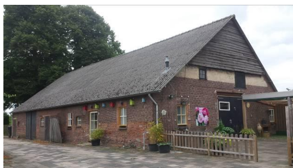
Foto links: links in beeld de sparing waarin zich de voordeur bevonden heeft met hierboven het dichtgezette bovenraam, rechts de plaats van het woonhuisraam in de lange gevel. Duidelijk is op deze foto te zien dat de gevel in twee fasen gebouwd is: eerst het onderste deel uit halfweg de 19 e eeuw, vervolgens een ophoging van rond 1900.
