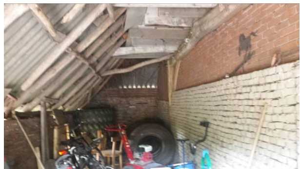
Foto links: achterzijde van de westgevel met het varkensdeurtje | foto rechts: binnenzijde van de afdang/karschop met rechte de kopgevel van de hoofdbouw van de boerderij, met onder cementstenen en hierboven bakstenen uit de jaren '90 en het gebint in de muur.
