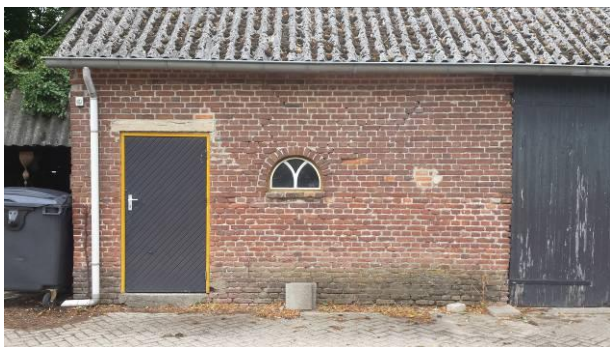
Foto links: de toegevoegde toegangsdeur met betonlatei, hiernaast het halve maantje. Foto rechts: de nog aanwezige grote deeldeuren.
