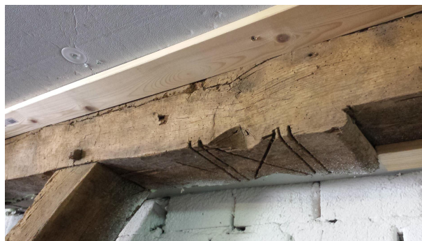
Sleutelstuk in de ankerbalk op as C, op de linker foto het sleutelstuk nabij C2, op de rechter foto het sleutelstuk nabij as C4.
