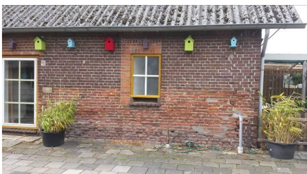
Foto links: links in beeld de sparing waarin zich de voordeur bevonden heeft met hierboven het dichtgezette bovenraam, rechts de plaats van het woonhuisraam in de lange gevel. Duidelijk is op deze foto te zien dat de gevel in twee fasen gebouwd is: eerst het onderste deel uit halfweg de 19 e eeuw, vervolgens een ophoging van rond 1900.
