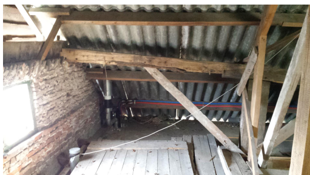
Foto links: verlengde muurplaat aan de woonhuiszijde (as 2 tussen A en B)
