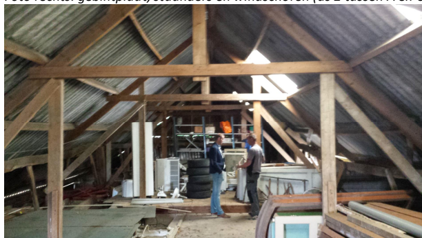
Foto links: overzicht over de huidige zolder met kapspanten uit de vorige eeuw en een vlakker dak met golfplaten.
