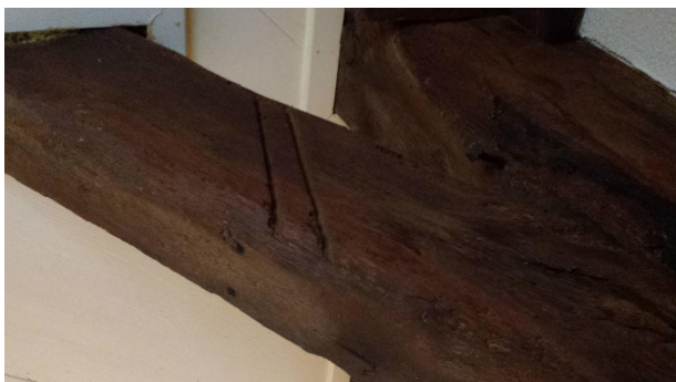
Nummering van de gebinten, links twee sneden als nummering 2, rechts twee puntjes als nummering 2.
