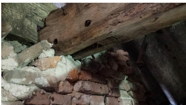
Foto links: gat waarin zich een stijl bevonden heeft ter binnenzijde van de huidige gemetselde kopgevel (op as A2) Foto rechts: ligger als muurplaat waarop het wolfseind van de kap bij de gemetselde kopgevel rust (op as A2), is in het verleden niet ondersteund geweest door metselwerk maar ligt zowel links als rechts op de aan de voorzijde verlengde gebintplaat op.
