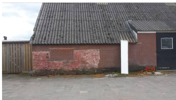
Foto rechts: linker deel van de lange noordgevel met hierin ouder metselwerk ter plaatse van de voormalige kelder.
