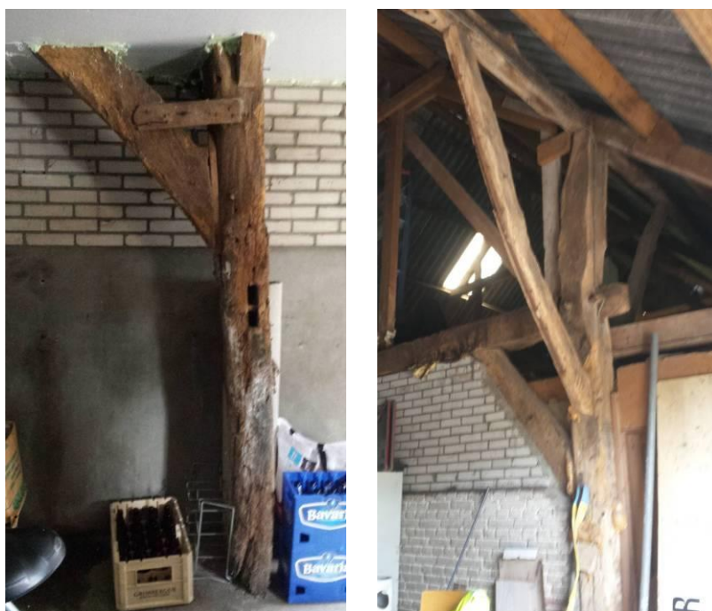
De gebintstijlen op respectievelijk, D2 en E2 (zie stramienindeling plattegrond)
