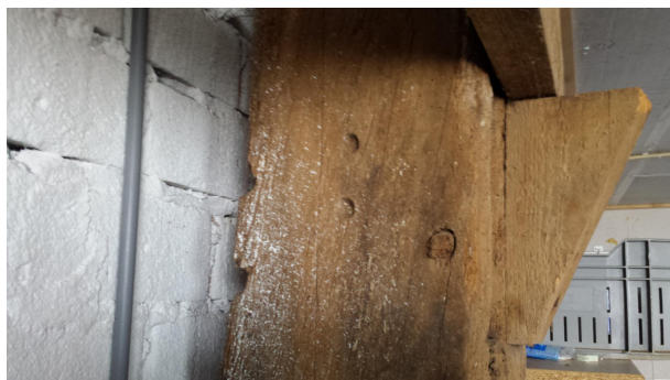
Nummering van de gebinten, links twee sneden als nummering 2, rechts twee puntjes als nummering 2.
