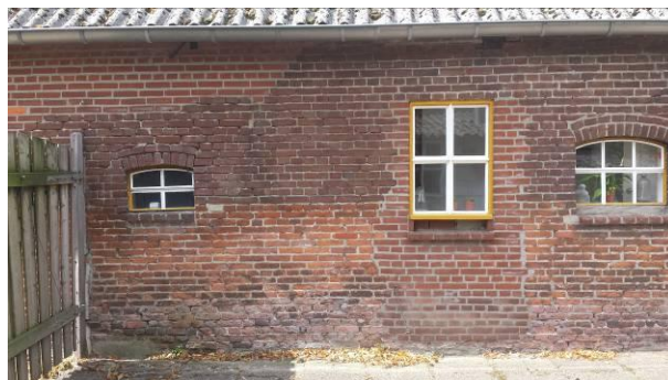
Foto links: de dicht gezette sparing van de voormalige mestdeuren, hierbij vervangen door een loopdeur en en stalen raampje.
