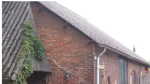
Foto links: gebint in de kopgevel van de hoofdbouw van de boerderij, binnen in de afdang/karschop | foto rechts: sporen van gefaseerde ophoging van de daklijn in de kopgevel als gevolg van ophogen van de zuidgevel en aanpassingen aan de kap.
