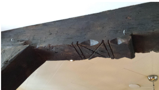
Sleutelstuk in de ankerbalk op as C, op de linker foto het sleutelstuk nabij C2, op de rechter foto het sleutelstuk nabij as C4.
