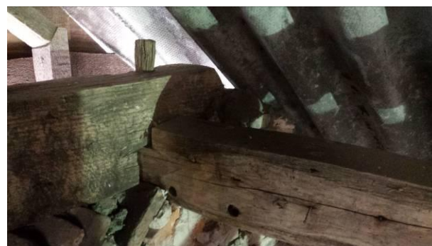
Foto links: gat waarin zich een stijl bevonden heeft ter binnenzijde van de huidige gemetselde kopgevel (op as A2) Foto rechts: ligger als muurplaat waarop het wolfseind van de kap bij de gemetselde kopgevel rust (op as A2), is in het verleden niet ondersteund geweest door metselwerk maar ligt zowel links als rechts op de aan de voorzijde verlengde gebintplaat op.
