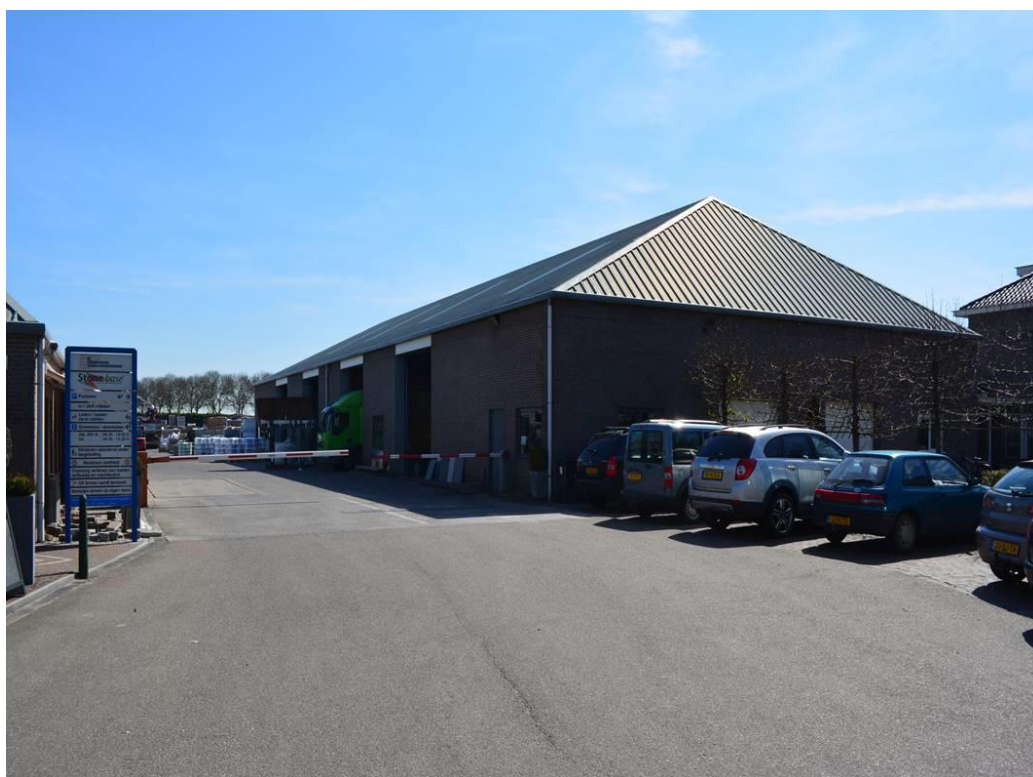
Figuur 4 Zijgevel van de werkplaats en toegang naar het opslagterrein (foto aangeleverd door dhr. N. van Hooijdonk).
