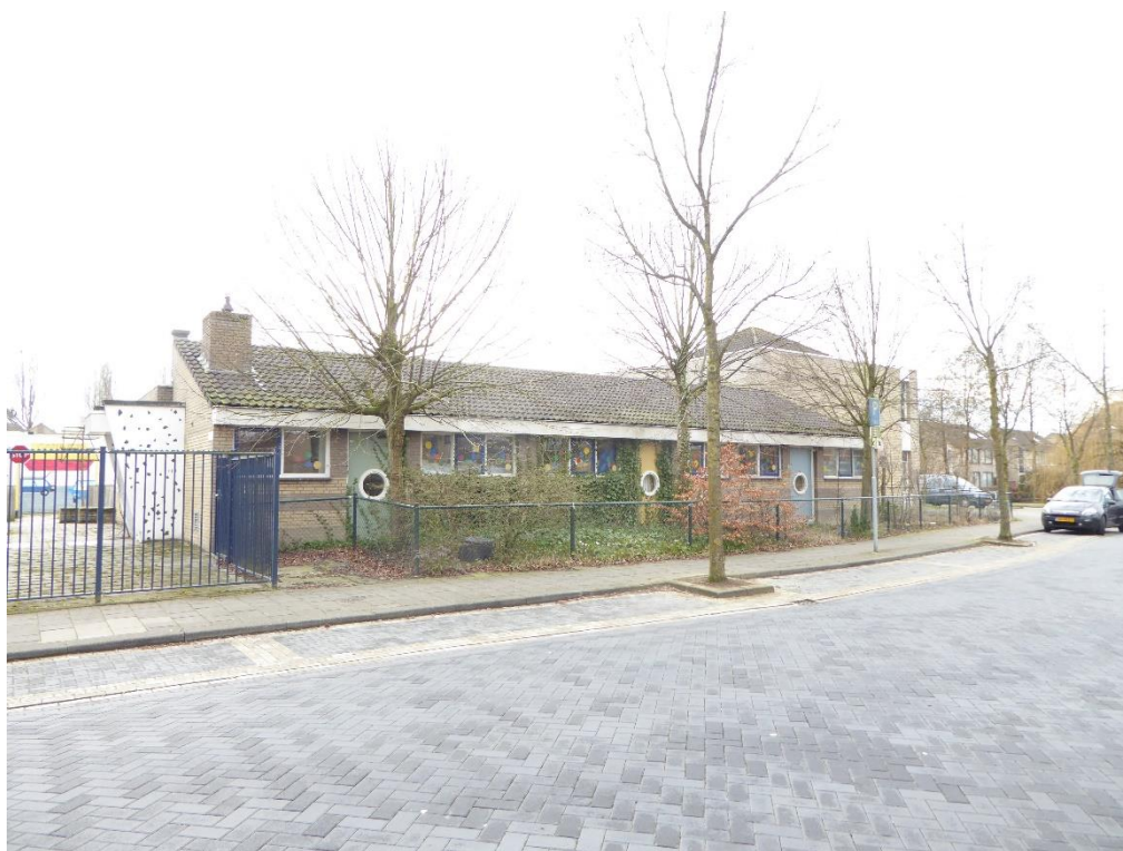
Figuur 4. De voormalige school aan de Zwartbroekweg, gezien vanaf de oostzijde.
