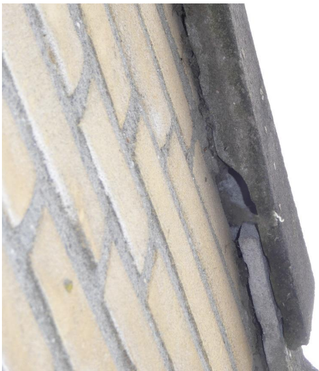
Figuur 6. Onder de dakpannen zijn kieren aanwezig waarlangs vleermuizen mogelijk in de spouw kunnen komen.
