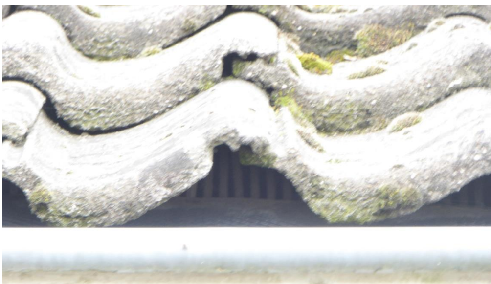
Figuur 6. Onder de dakpannen zijn kieren aanwezig waarlangs vleermuizen mogelijk in de spouw kunnen komen.
