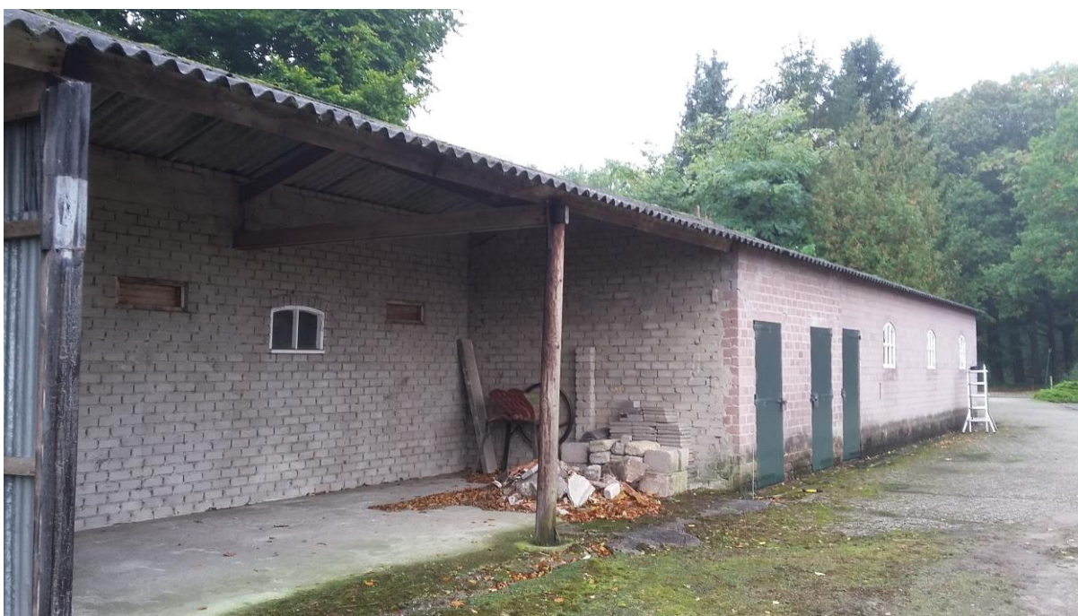
Figuur 8. Opslagruimte bij de voormalige koeienstal.
