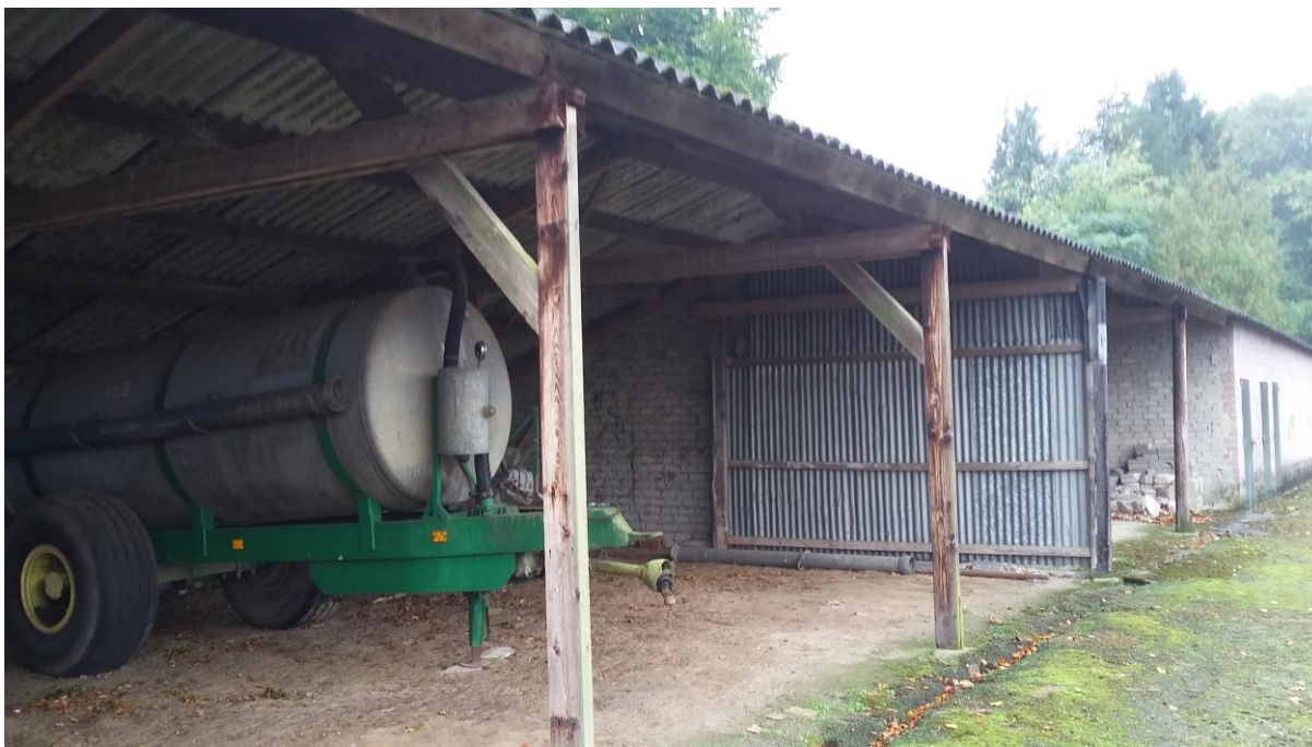
Figuur 7. Opslagruimte bij de voormalige koeienstal.
