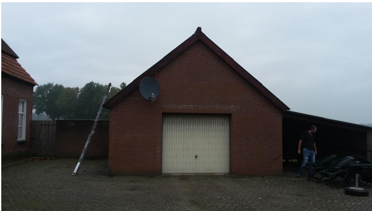
Figuur 5. Het te slopen schuurtje met carport.
