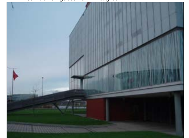
Parkeren onder het gebouw
