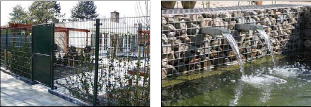
Klimplanten, schanskorven of ander los vulmateriaal
