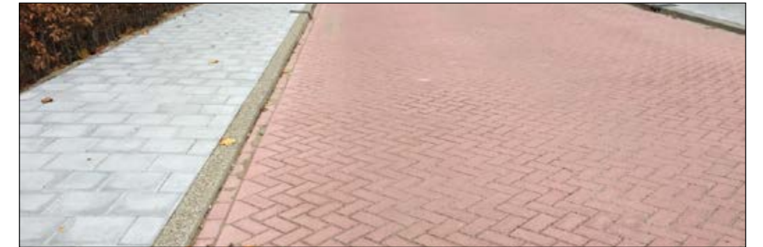
Rode beton klinkers en 30x30cm tegels
