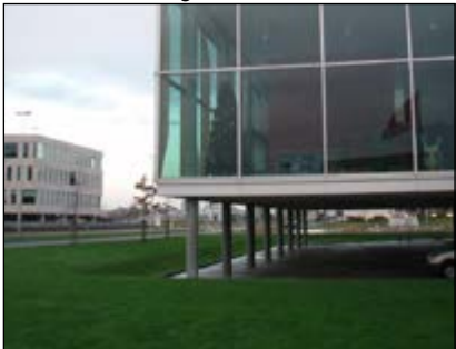
Parkeren onder het gebouw
