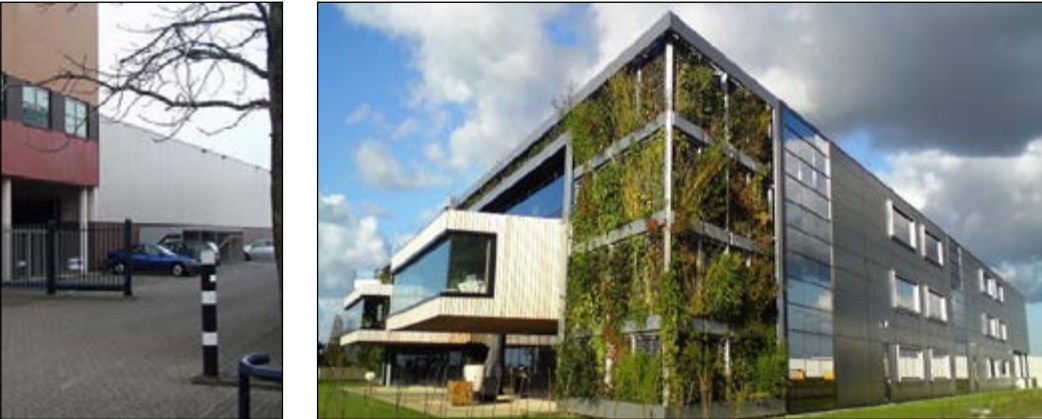
Hekwerk gesitueerd achter de gevellijn
