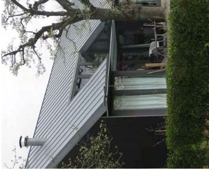
Een uitsparing uit gevel en dak ten behoeve van meer licht/ramen op de verdieping.
