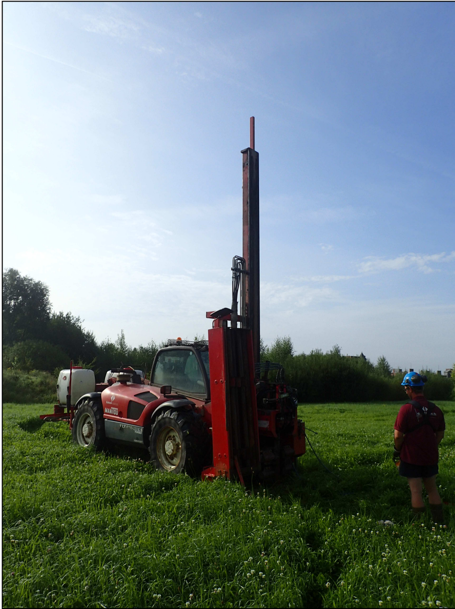
Figuur 6: De Aqualockboor op een Manitou-tractor in het plangebied.
