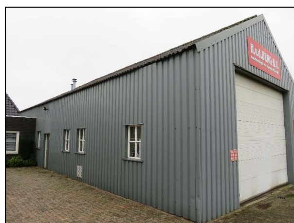
Foto 10: te slopen garage noordwestzijde
