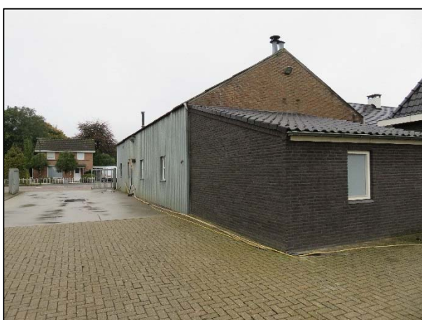
Foto 9: te slopen garage zuidoostzijde
