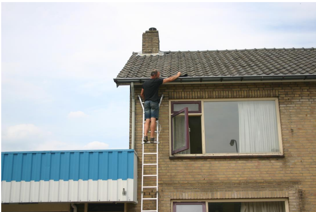
Figuur 4. Inspectie van de onderste dakpannen van het woonhuis.
