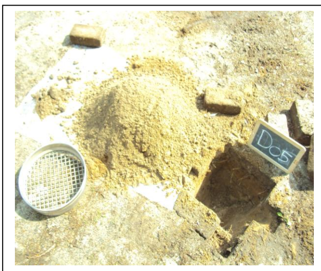
Foto asbestinspectiegat D05
