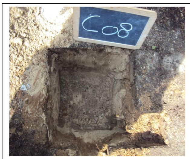
Foto asbestinspectiegat C08
