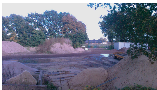
Beslotenheid huidige terrein gezien vanaf het Heeseind
